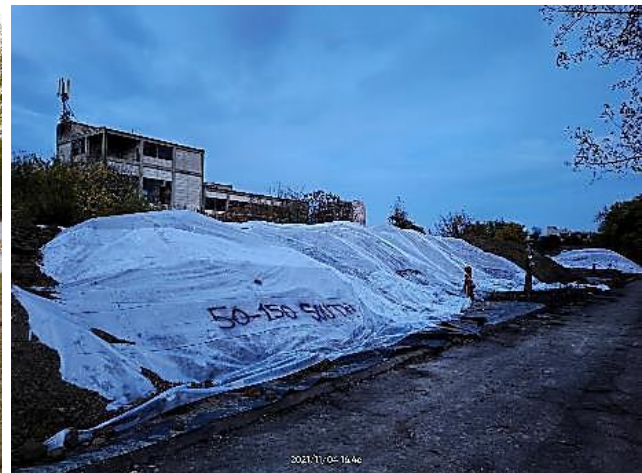
Покривање на ископаната почва издвоена на посебно депо
