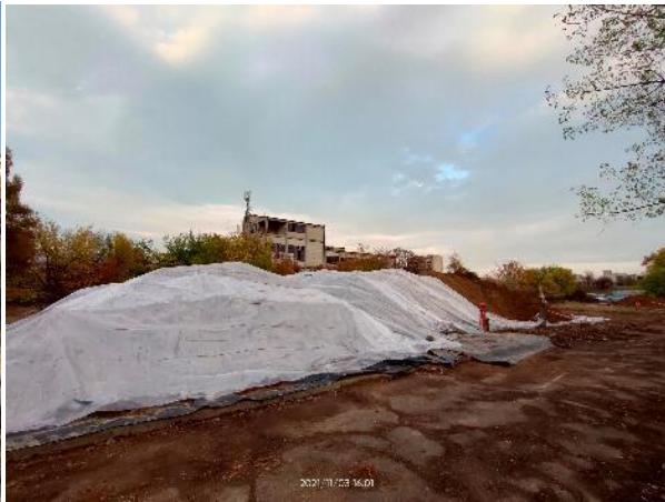
Истовар на ископаната почва и нејзино покривање заради изолација од околината
