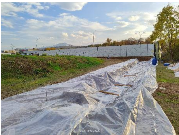
Покривање на ископаната почва издвоена на посебно депо
