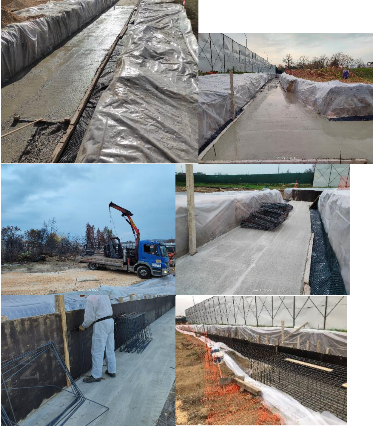
Бетонирање и истовар и поставување на метална арматура
