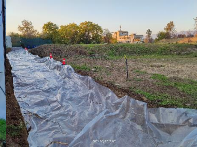
Поставување на фолија во ископот за темелите со цел изолација од потенцијално контаминиран материјал
