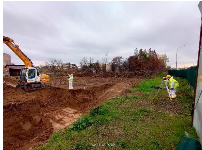
Ископ на источната страна од ровот и геодетски мерења
