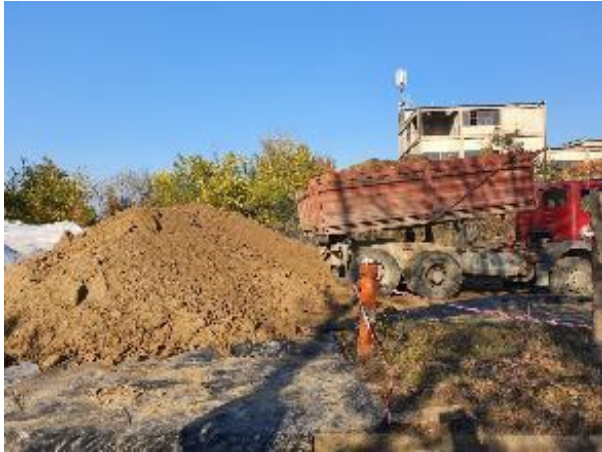
Истовар на ископаната почва и нејзино покривање заради изолација од околината
