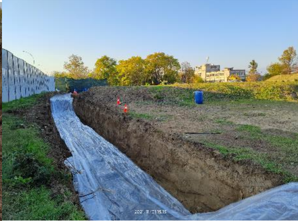
Истовар на ископаната почва и нејзино покривање заради изолација од околината
