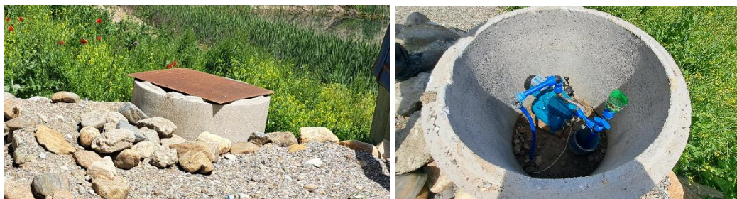
Слика 21 Хидрофор за вода
