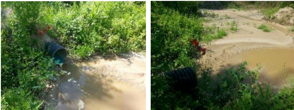
Слика 4 Точка на испуст на отпадните води
