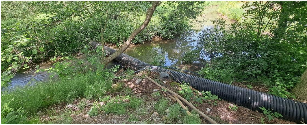
Слика 3 Цевка за одведување на отпадните води во земјен таложник
