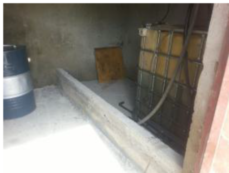
Слика 3 Резервоар за нафта
