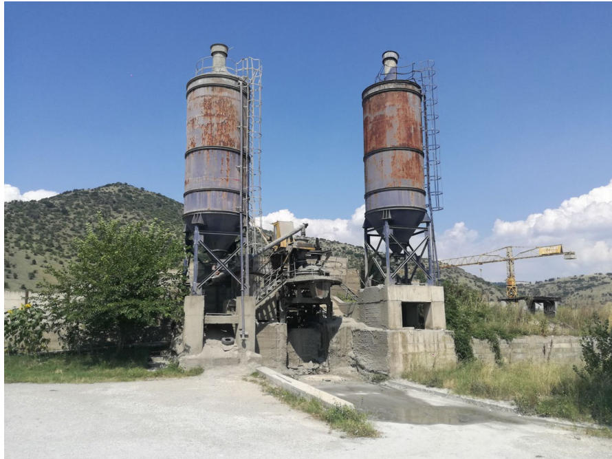
Слика 6 – Бетонска база
