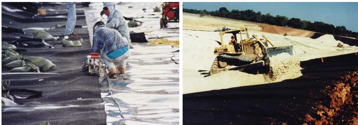
Слика 12 Термичко заварување на краевите на синтетичката подлога (лево) и покривање на геотекстилот со дренажен слој од крупнозрнест чакал (десно)
