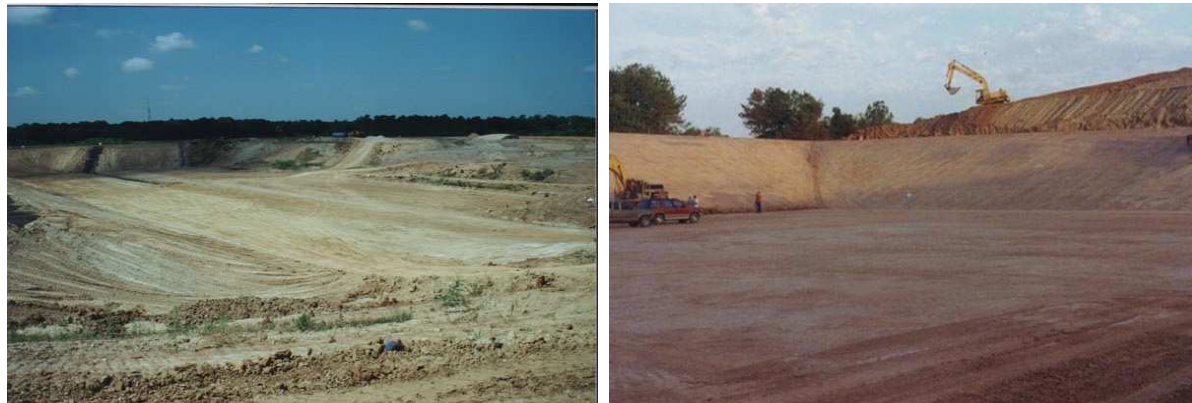
Слика 9 Припрема на подлога за нова депониска ќелија (лево) и припремен терен за поставување на синтетичката подлога (десно)
