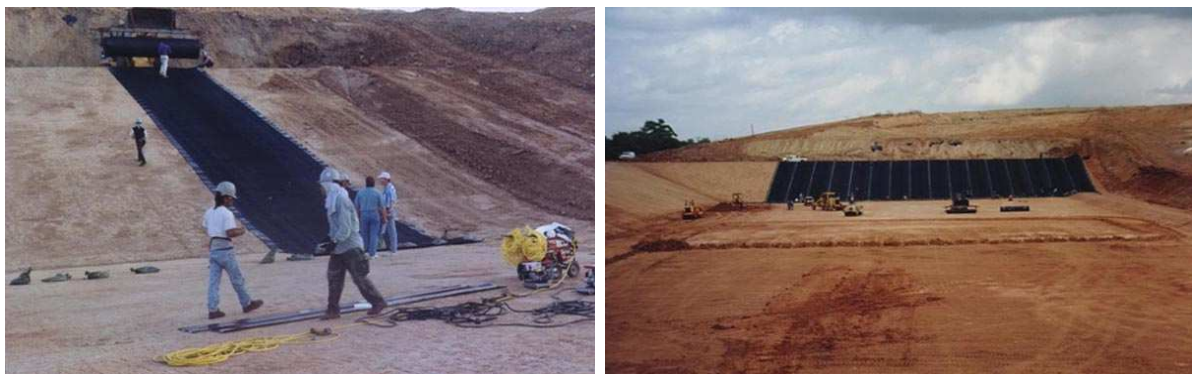
Слика 10 Поставување на синтетичката подлога геомембрана
