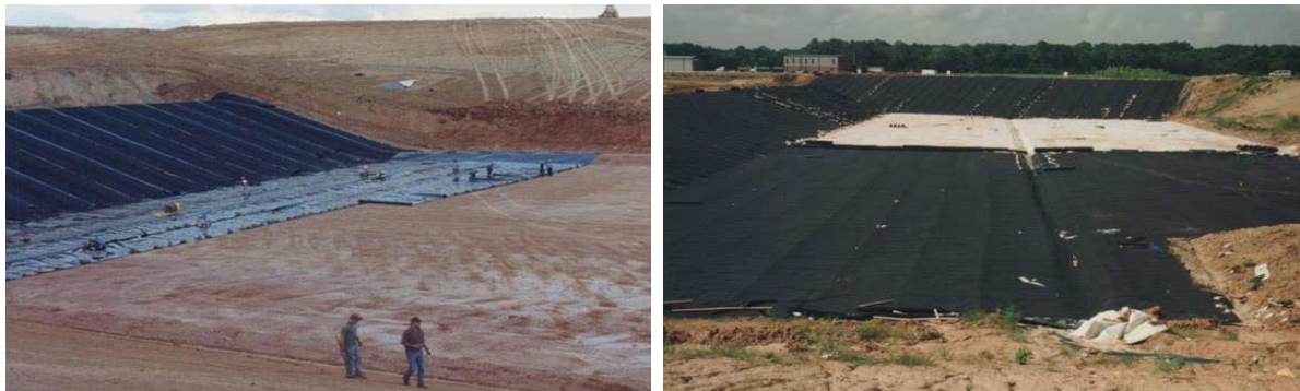
Слика 11 Поставување на заштитна синтетичка подлога од геотекстил
