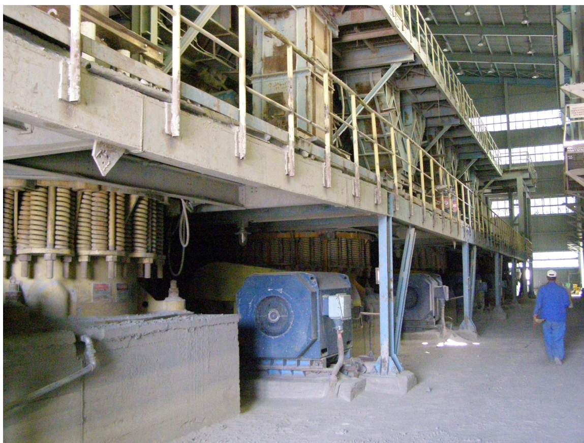
Слика 2.3.1 Поглед на приземјето на халата за секундарно и терцијарно дробење. (Во предниот дел е фундамент на една од Симонс дробилките со амортизационите федери и високонапонскиот мотор за погон)
